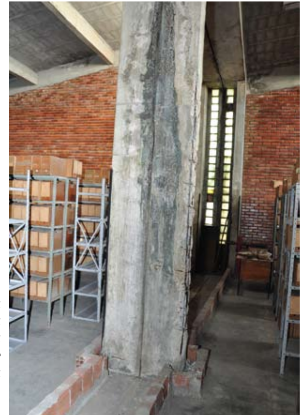
O espaço está com a estrutura das colunas à mostra e enferrujada
